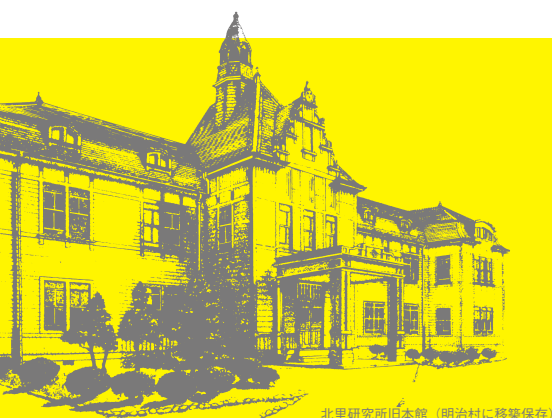
北里研究所旧本館 (明治村に移築保存)
