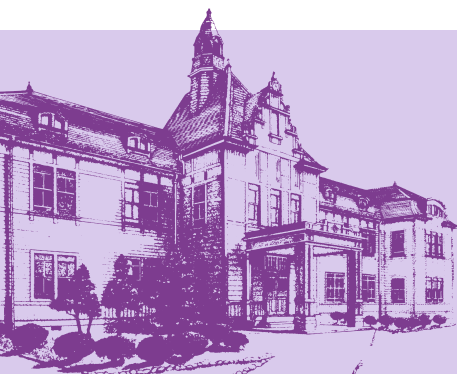
北里研究所旧本館 (明治村に移築保存)
